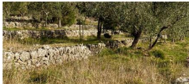
Restanques de pierres sèches (meulière)
