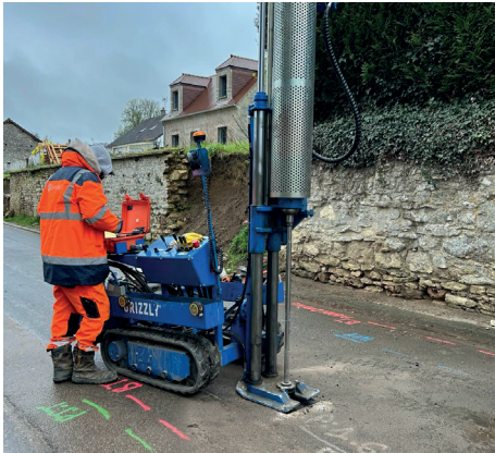
Mesure de la résistance du sol après travaux rue du Clos de l'Isle
