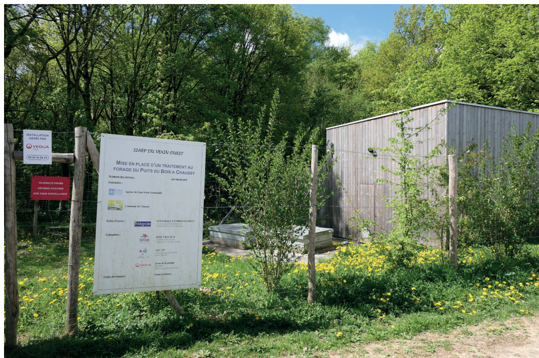
Puits du bois : captage d'eau pour le village
